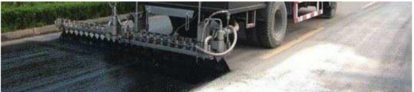
Bitume ed acqua possono formare un'emulsione se miscelati vigorosamente, ma si separano immediatamente quando finisce la miscelazione, di conseguenza, un'emulsione per essere stabile deve contenere un terzo componente: l'emulsionante.
