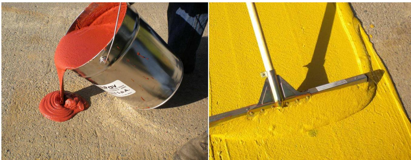
L'applicazione di **RESINPAV**, oltre al notevole impatto estetico, prolunga la vita degli asfalti, favorendo la compattezza ed il consolidamento, rendendo le pavimentazioni resistenti anche ai carburanti ed ai lubrificanti.
