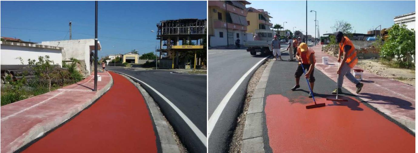
La seconda mano di applicazione può essere fatta quando la prima è completamente asciutta, in ogni caso entro le 24 ore. Il rivestimento applicato è resistente al passaggio del traffico pedonale entro le prime 24-48 ore, a seconda delle condizioni ambientali. La durezza massima viene raggiunta dopo 2-3 giorni.
