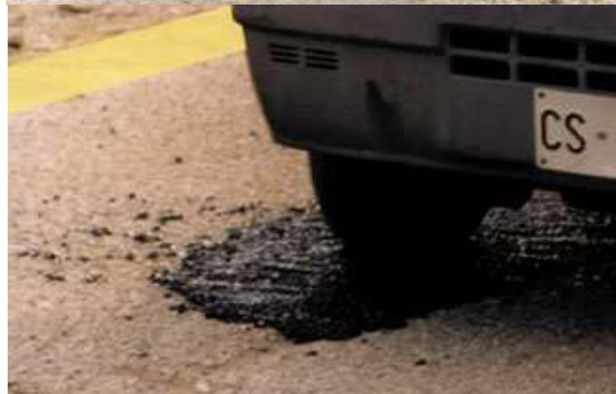
Un conglomerato plastico lavorabile a temperatura ambiente è ottenuto aggiungendo una certa percentuale di additivo "**Flussante**" ad una miscela bitume-aggregato.
