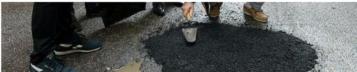
I conglomerati plastici studiati nei laboratori della Star Asphalt SpA, sono stati prodotti variando le percentuali di dosaggio e la tipologia di additivo **STAROIL®**. I conglomerati esaminati sono stati ottenuti impiegando come legante del bitume 70/100 e due tipologie di inerti: graniglia 3/6mm e sabbia 0/4mm.
